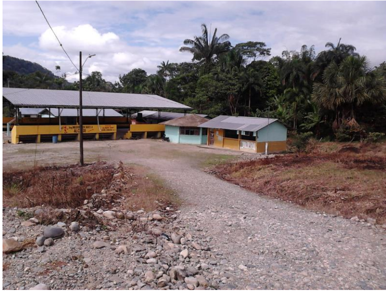
Foto No 2 Guinea Chimbana: escuela con cancha cubierta, aulas con vida útil por concluir.
