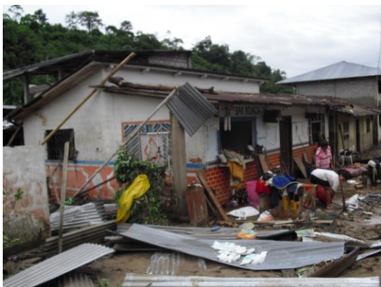
Foto No 6 Afectación comunidad Ongota Información: pública 2010
