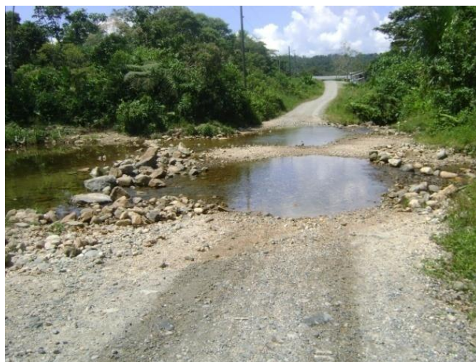
Foto No 9. Vía de ingreso a Pumayacu
