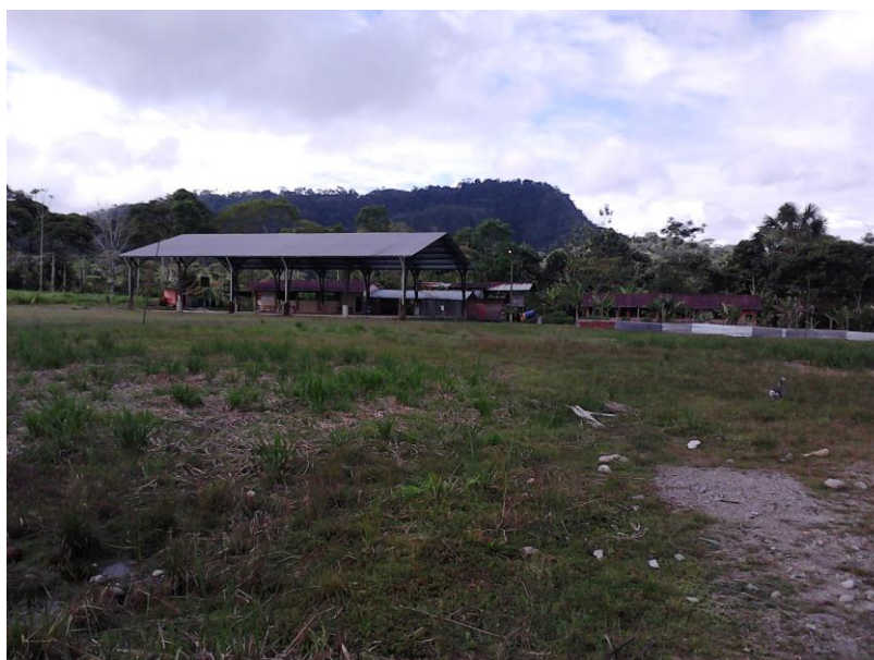
Foto No 1 Alto Pano: escuela con cancha cubierta, aulas con vida útil por concluir
