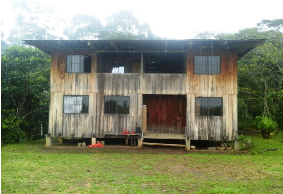
Fuente: Mario Chauzá (2015) (Nuevas instalaciones para alojar turistas construidas en el 2009).
