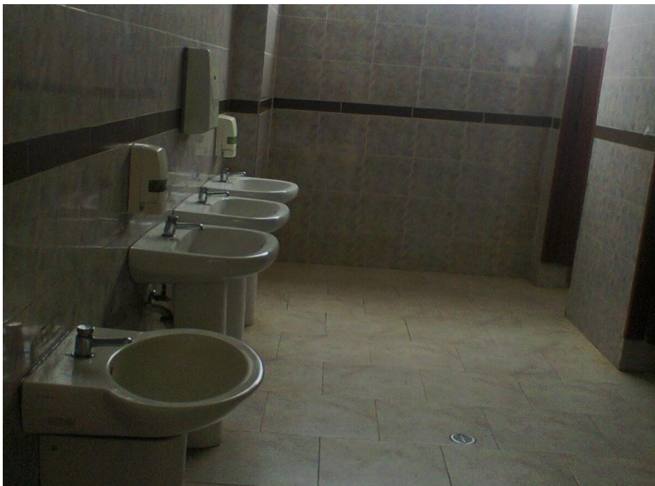
Figura 9: Baños de la Unidad Educativa del Milenio Intercultural Bilingüe “Pueblo Kisapincha”
