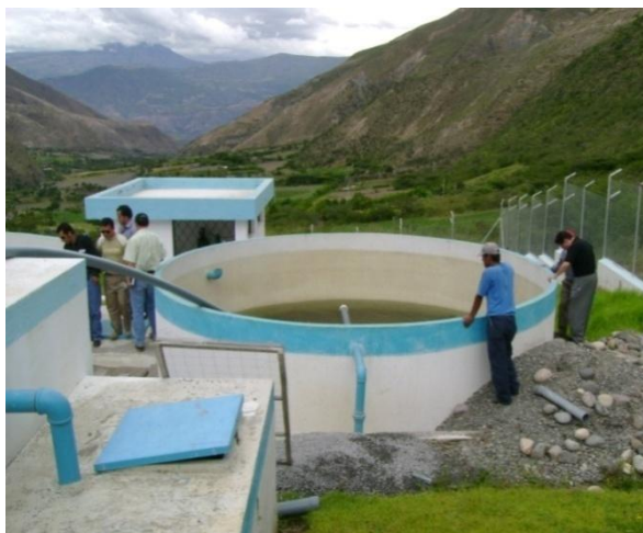
Foto N° 12. Planta de tratamiento de Ambuquí
