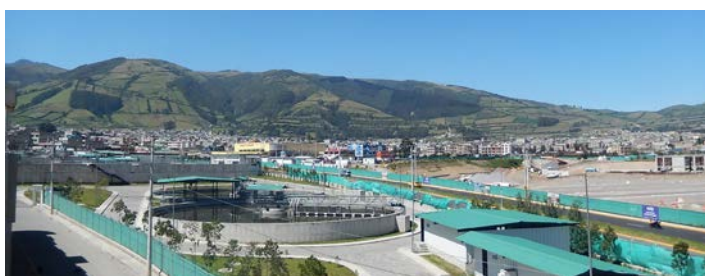
Imagen 6: Planta de tratamiento de aguas residuales de Quitumbe. Fuente: IMPU 2017.
