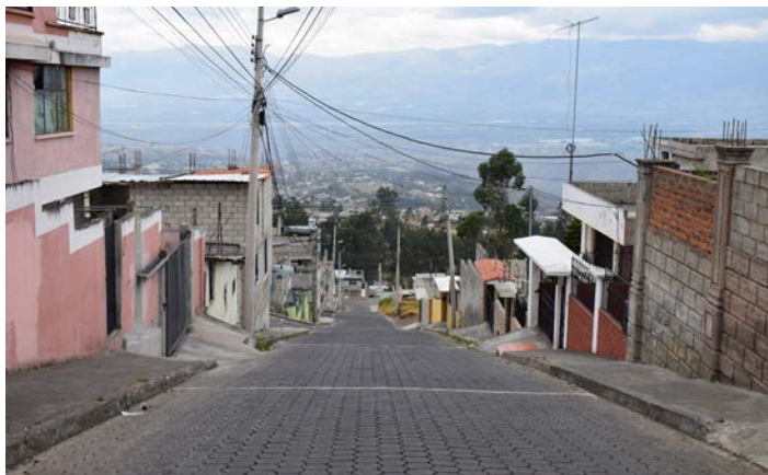
Imagen 1: Barrio en el norte de Quito: traza urbana inconexa y desarticulada; Espacio público despensalizado, poco convocante e inseguro. Fuente: IMPU.
