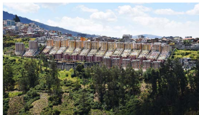
Imagen 16: Proyecto inmobiliario en el centro norte de Quito: ubicado en borde de quebrada y en condición de riesgo. Fuente: IMPU
