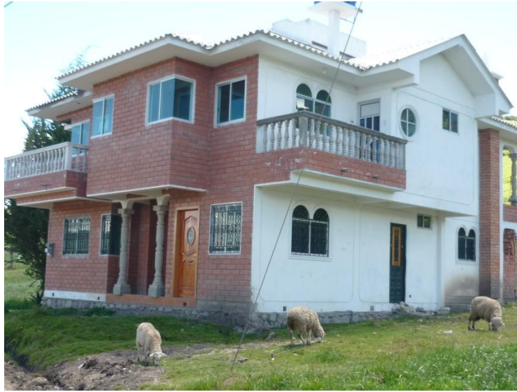
Vivienda en la comunidad de Sisid construida con remesa migrante
