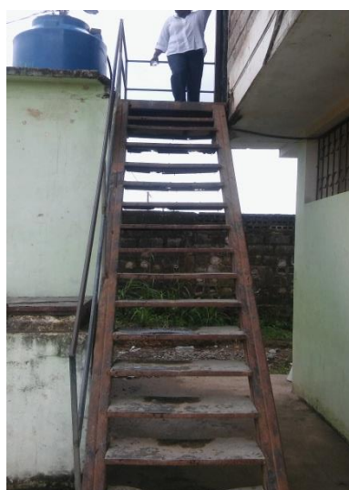
Escaleras para acceder al 7mo B
