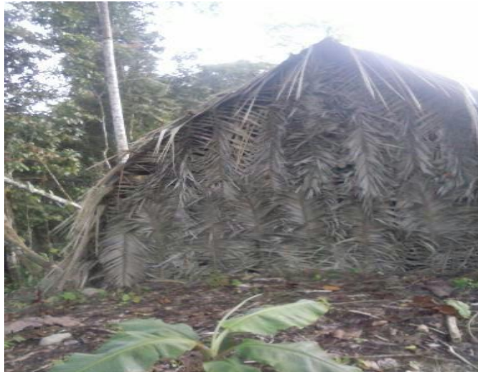
La construcción ya terminada para vivir la casa típica
