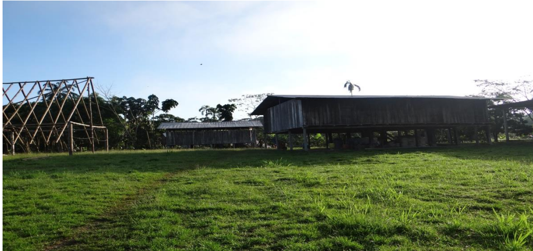
Nueva forma de construir la casa típica
